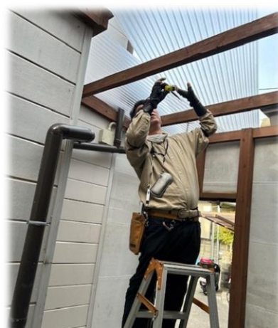
喫煙室に雨除けの屋根を設置!
